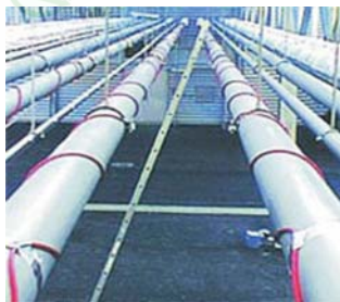
Режим №3 технологический трубопровод
